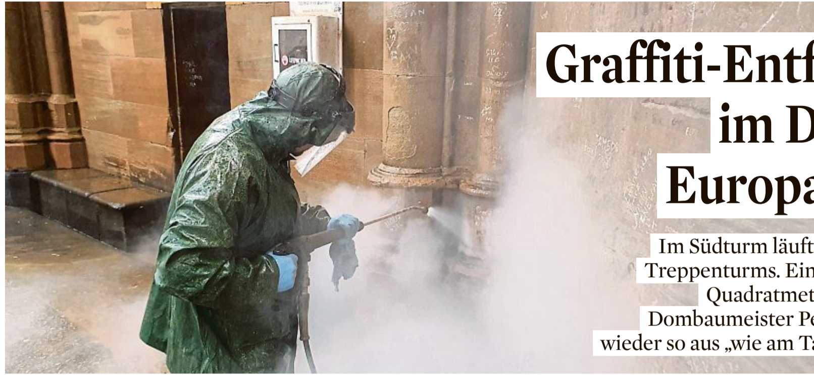
Mit einem Hochdruckreiniger werden die Graffiti entfernt, die Dombesucher über Jahrzehnte hinweg an den Wänden des Treppenturms hinterlassen hatten.
