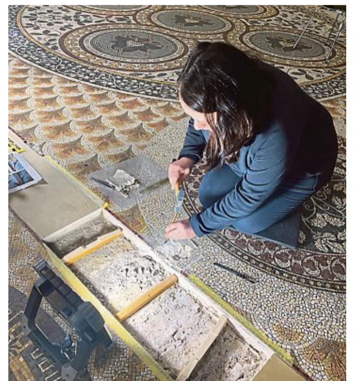
Restauratorin Sandra Williger von der Dombauhütte bessert schadhafte Stellen des Mosaikfußbodens im Chorumgang aus.
