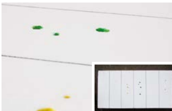
Abb. 8: Punktuelle Schäden durch Farbspray-Lösemittel
