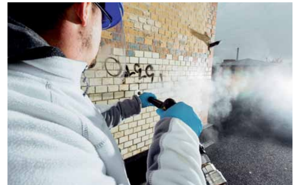
Oben: Schutzkleidung ist beim Entfernungsprozess unverzichtbar. Farben werden immer aggressiver und Chemikalien können die Gesundheit gefährden
